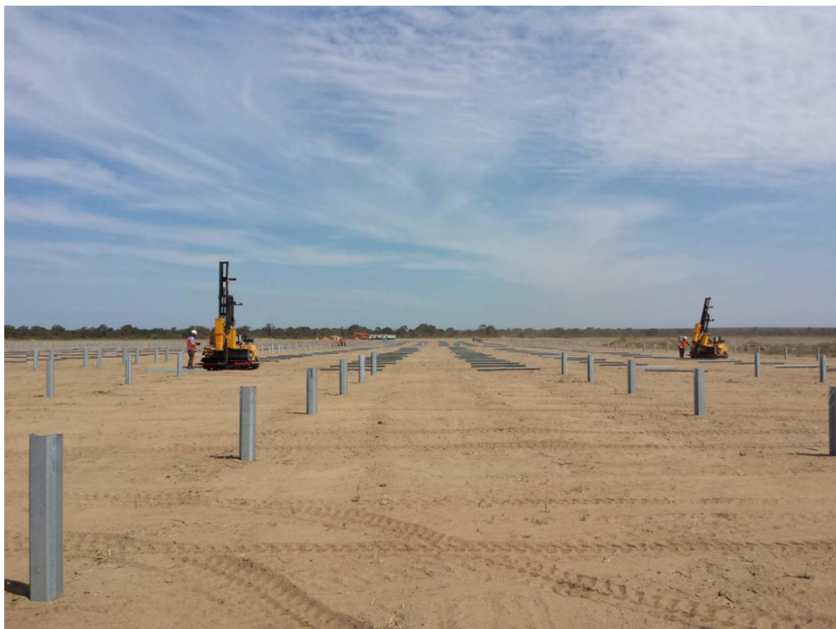
Figura 6.5 – Fase di infissione dei pali con profilo omega (fonte Convert)
