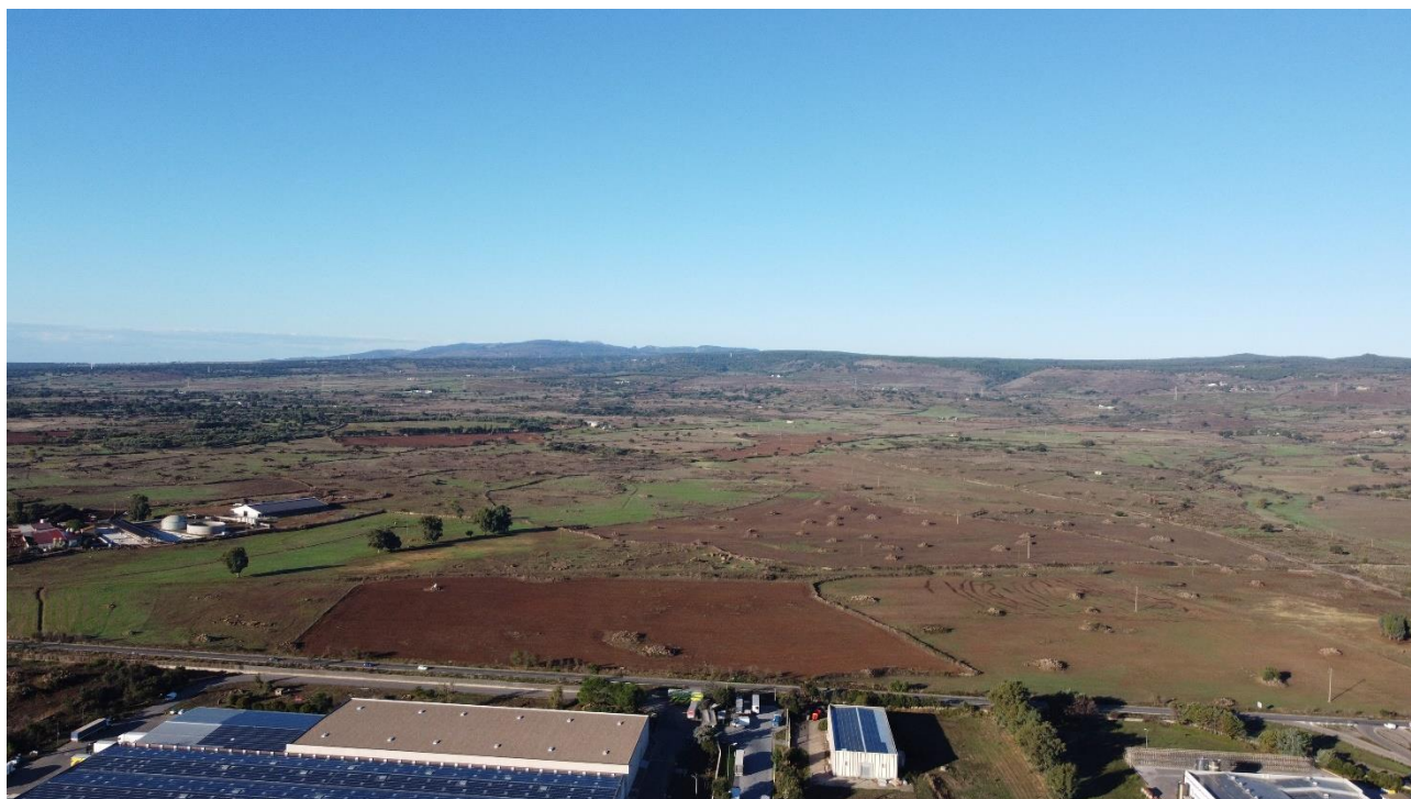
Figura 0.2 – Inquadramento area di impianto. Ripresa aerea dalla Zona Industriale di Tossilo, ad est, verso ovest. Sullo sfondo i rilievi del Montiferru (P.to 1)
