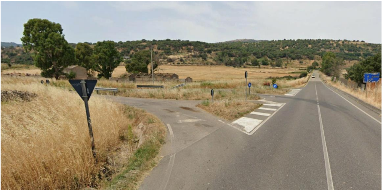
Figura 0.10 – Punto di innesto sulla Ex SS 131 dell'asse viario secondario lungo il quale corre il cavidotto a 36 kV. Foto estrapolata da Google Earth in direzione nord (P.to 9)
