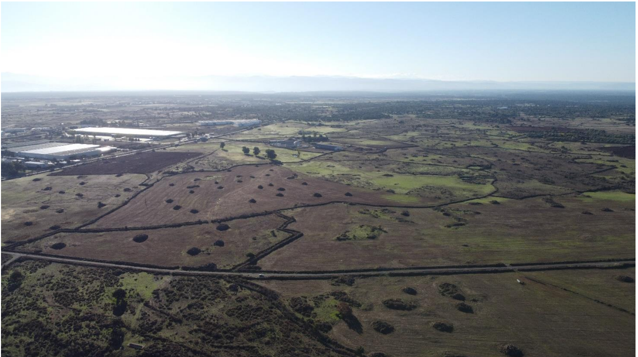
Figura 0.8 – Inquadramento area di impianto. Ripresa aerea da nord-ovest verso sud-est. Visibile l'asse viario secondario lungo il quale corre il tracciato del cavidotto a 36 kV e l'Area Industriale di Tossilo a sinistra (P.to 7)
