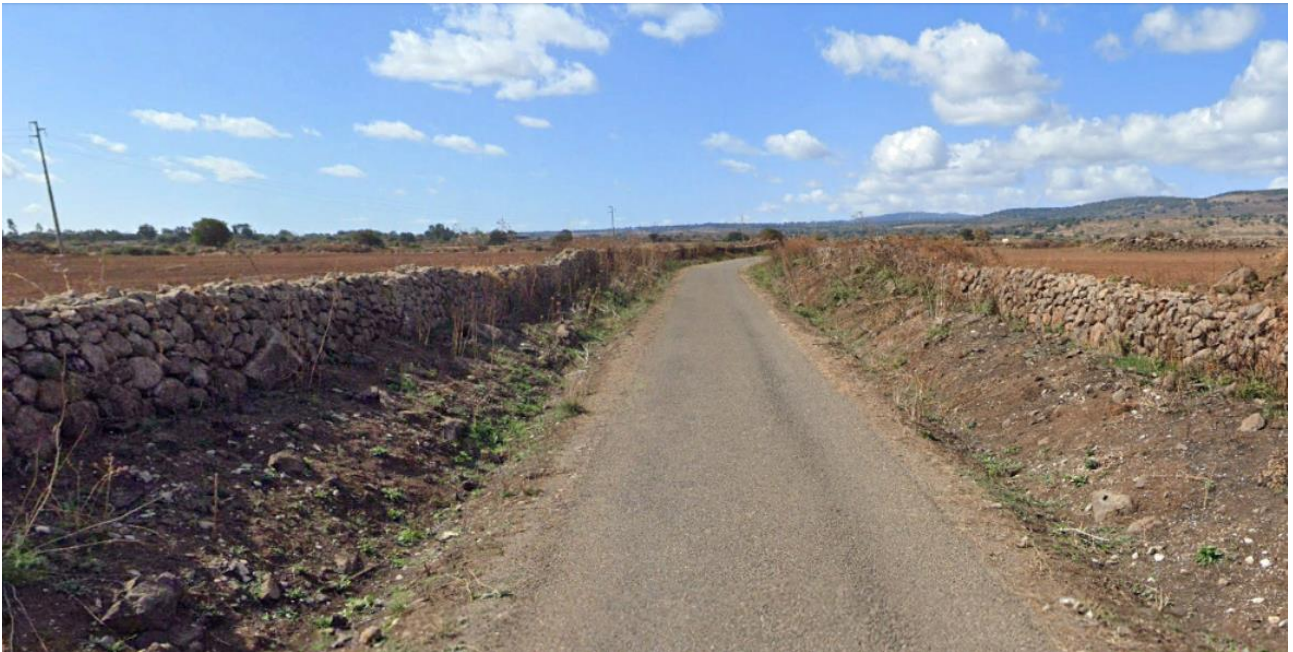
Figura 0.12 – Strada secondaria lungo la quale prosegue il tracciato del cavidotto. Foto estrapolata da Google Earth in direzione ovest (P.to 11)
