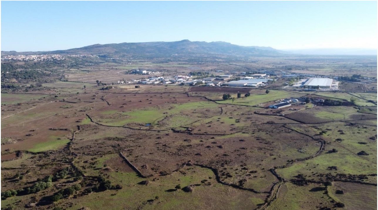
Figura 9.7 - Vista dell'area di impianto con foto scattata in direzione est. Sono visibili: l'area industriale di Tossilo; a sinistra il centro urbano di Macomer e sullo sfondo M. Santu Padre (catena del Marghine)
