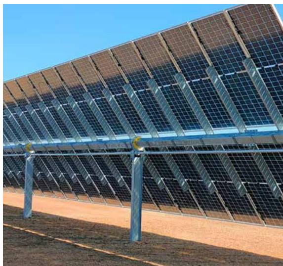
Figura 3 – Particolare Inseguitori mono assiali (Est-Ovest)
