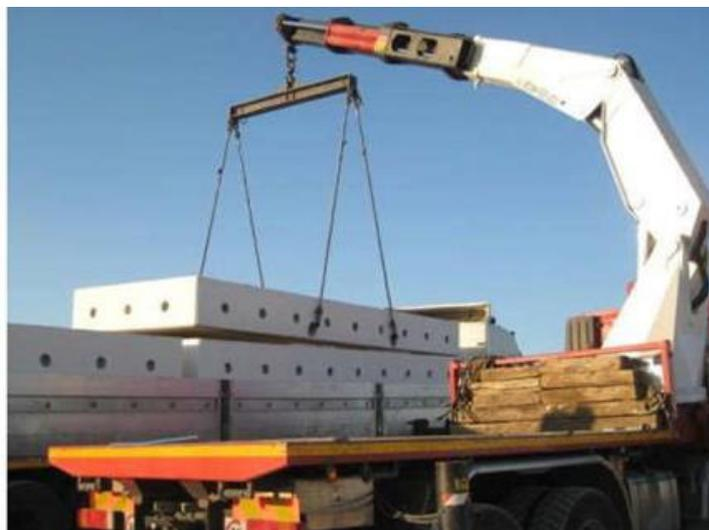
Figura 14 | Scarico cabina trasformazione
