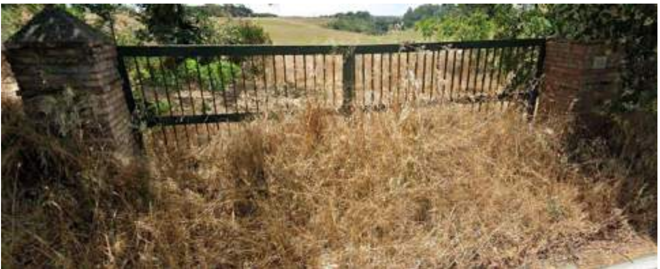
Fig. 3: immagine di uno dei probabili cancelli di accesso secondario all'area di cava
