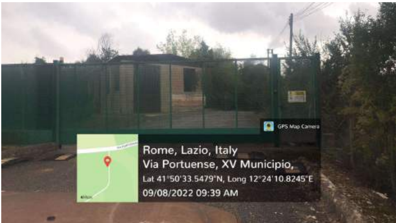
Fig. 1: Immagine dell'accesso principale alla zona di cava
