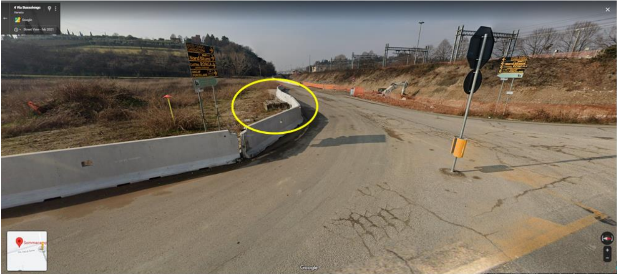
Foto 2 – dettaglio tombotto relativo al canale lungo la Via Bussolengo-SP26
