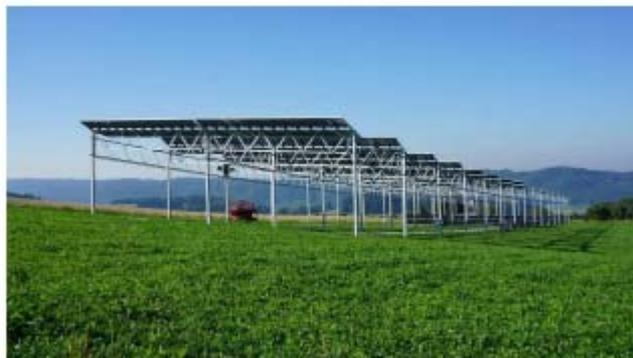
Le strutture saranno ancorate al terreno mediante piccoli plinti prefabbricati di fondazione aventi sezione quadrata di larghezza 100cm e altezza 100cm. Per ciascuna schiera si realizzeranno due di tali plinti in
