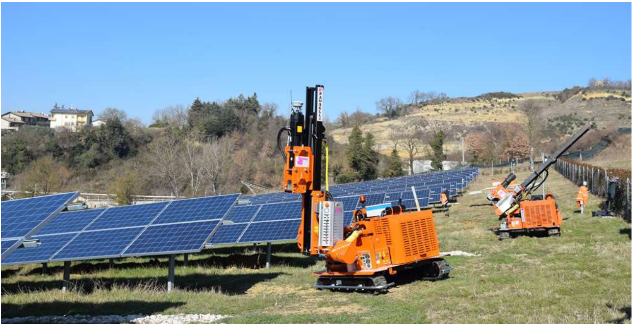
(Esempio di installazione di pali di fondazione mediante battipalo; fonte Pauselli Group, sito web)
