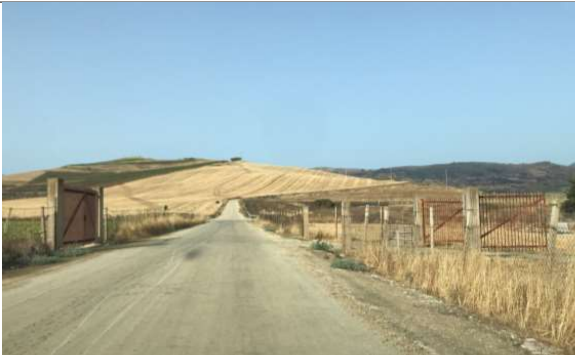
Cancelli di ingresso a Casa Giammarune (a destra) e al fondo antistante (sinistra) lungo la SP35
