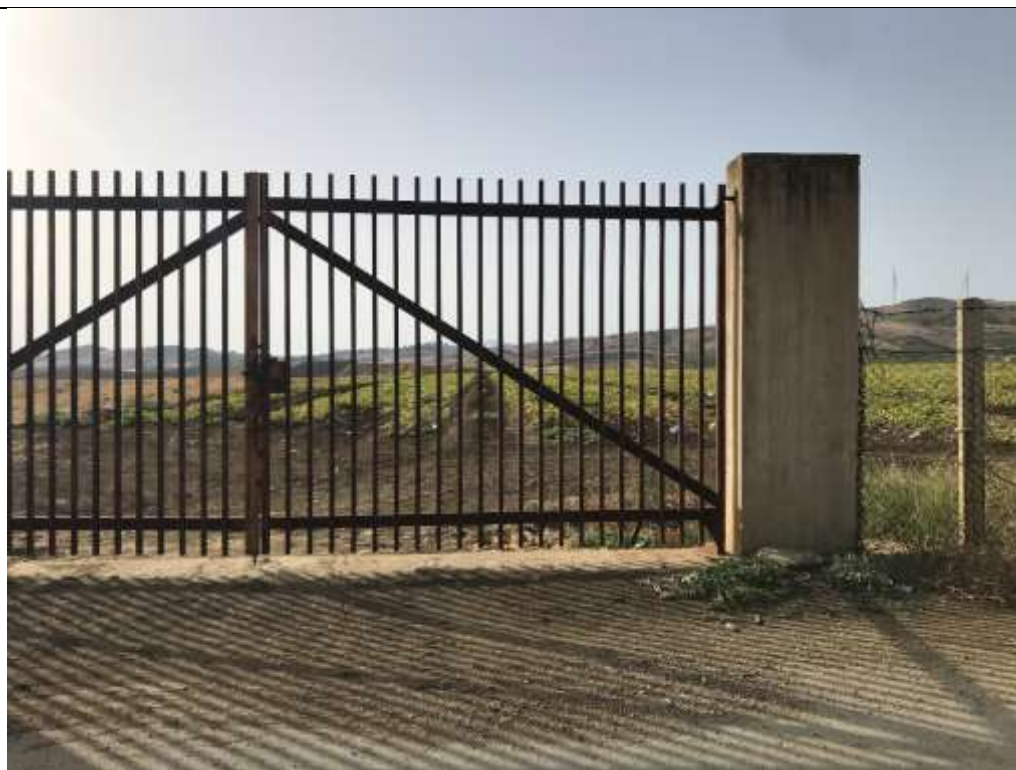
Vista del cancello sulla SP35 che costituirà uno degli accessi al nuovo impianto
