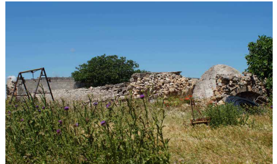
Masseria Rocco Nuzzo: foto allo stato di fatto
