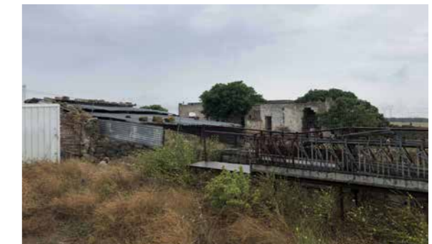
Foto masseria Roco Nuzzo, stato di fatto
