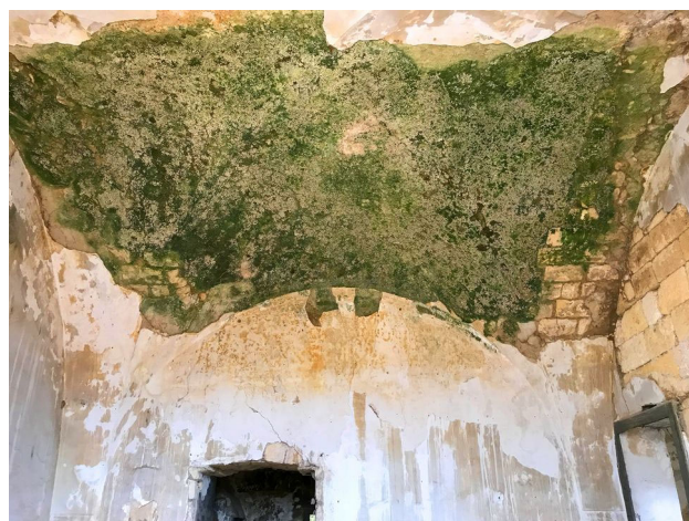
Foto 22. Nucleo antico della Masseria Dell'Erba. Particolare delle volte a squadro.
