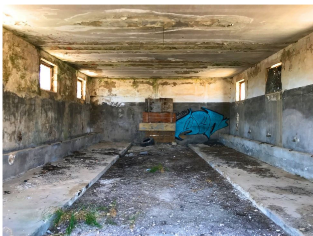
Foto 27. Masseria Dell'Erba. Interno delle stalle nuove ormai in disuso, probabilmente risalenti agli anni Cinquanta o Sessanta.
