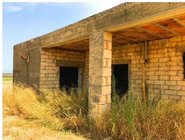
Foto 20. Fronte di Casa Grossi.
