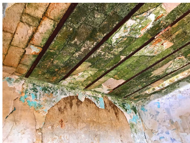
Foto 24. Locale di ampliamento della Masseria Dell'Erba. Particolare della volta a putrelle e archetti di conchi tufacei, probabilmente risalenti ai primi decenni del Novecento.
