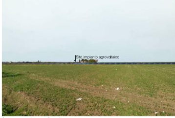
Cerignola, Inquadratura 1 - Stato di progetto. Vista impianto senza fascia di mitigazione e senza componente agricola esterna all'impianto.
