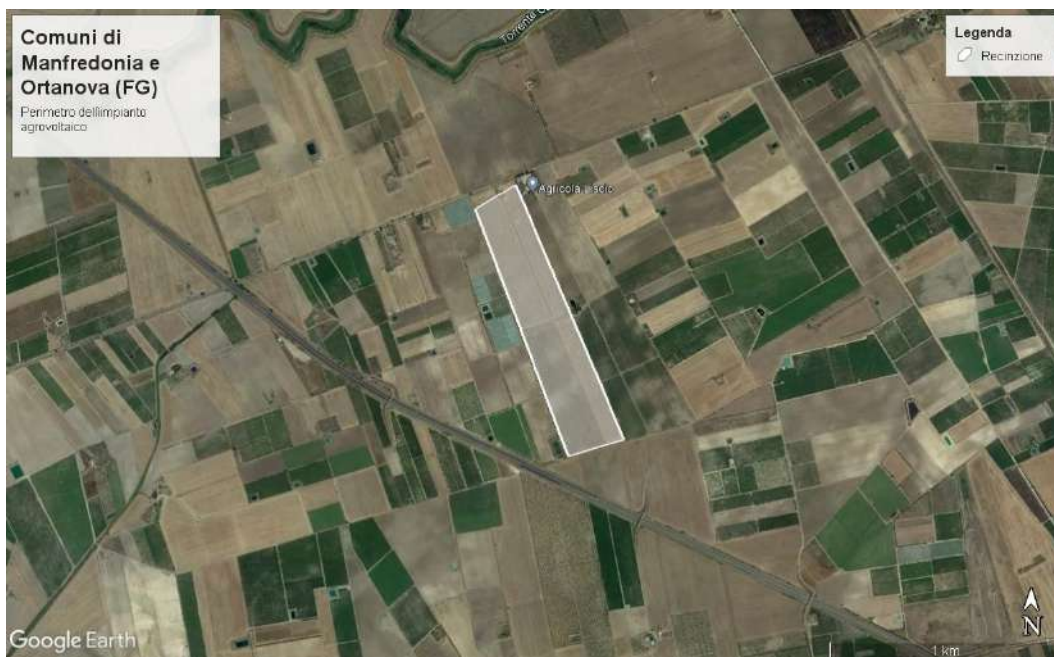
Figura 3-stralcio fotogrammetrico con area Orta Nova interessata da impianto
