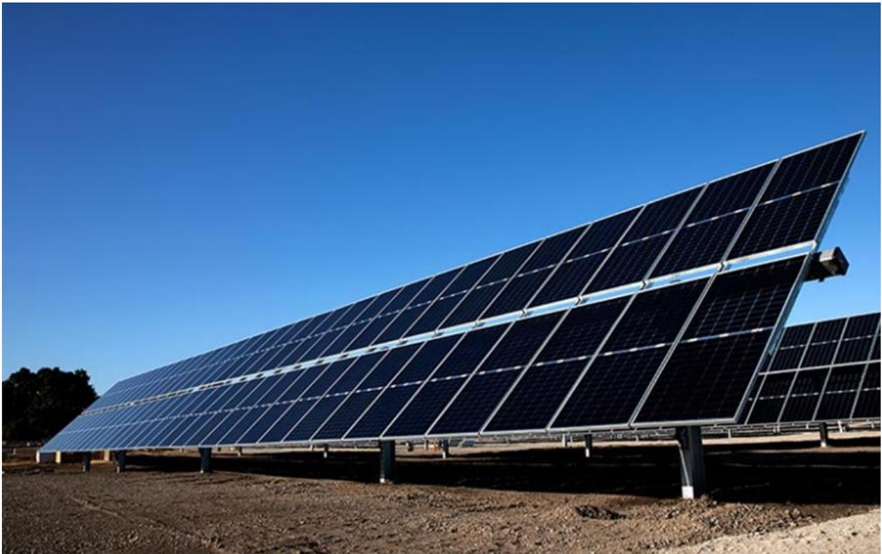
**Figura 4-9 – Tipico tracker fotovoltaico in configurazione "2-Portrait"**
