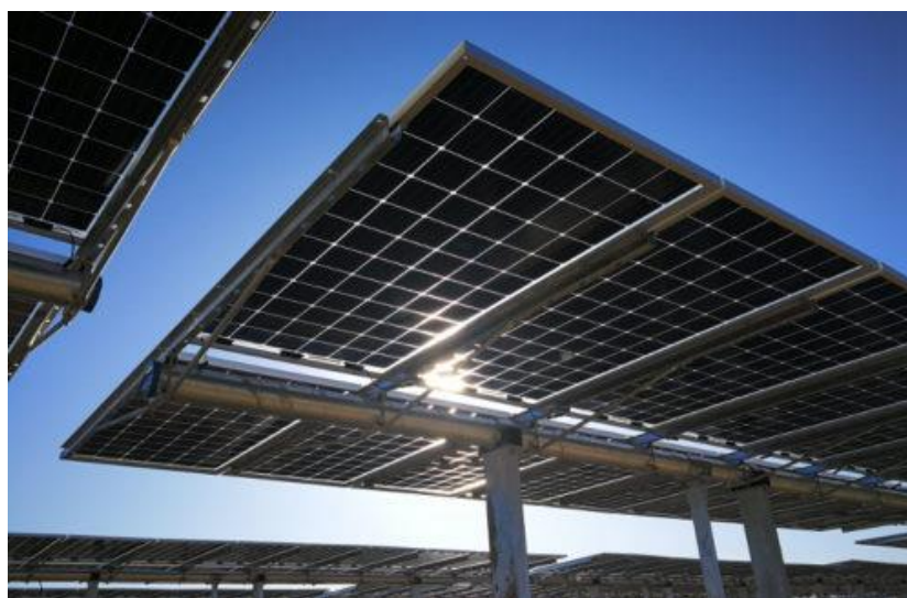
Figura 3.3 Esempio di struttura a tracker monoassiale
