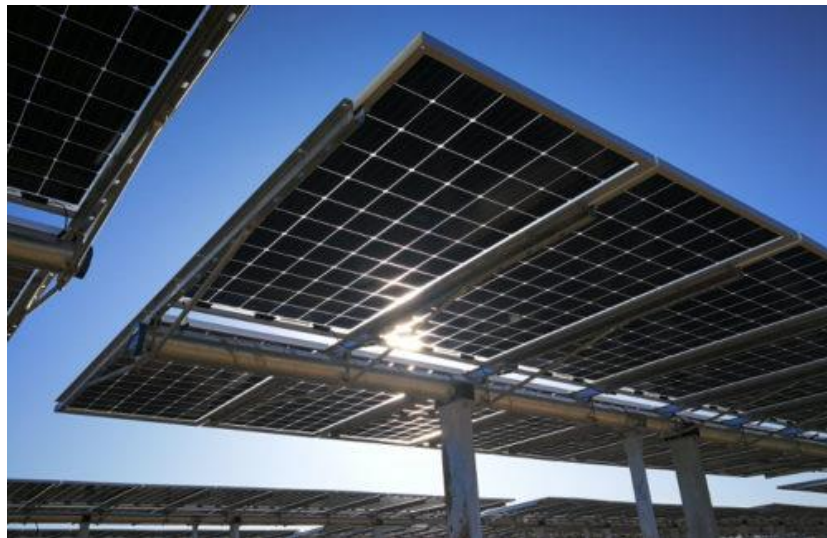
Figura 2.7 Esempio di struttura a tracker monoassiale
