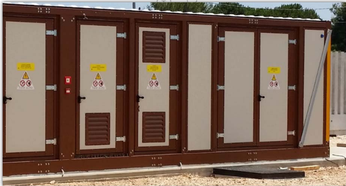
Fig. 5. Foto di edifici tipo shelter.
