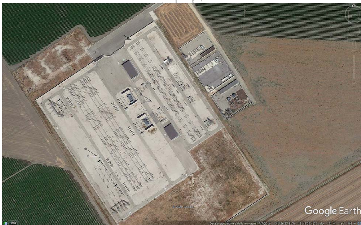
Fig. 9. Stralcio planimetrico su ortofoto su cui è evidente la parte della SE Terna realizzata ed in esercizio.
