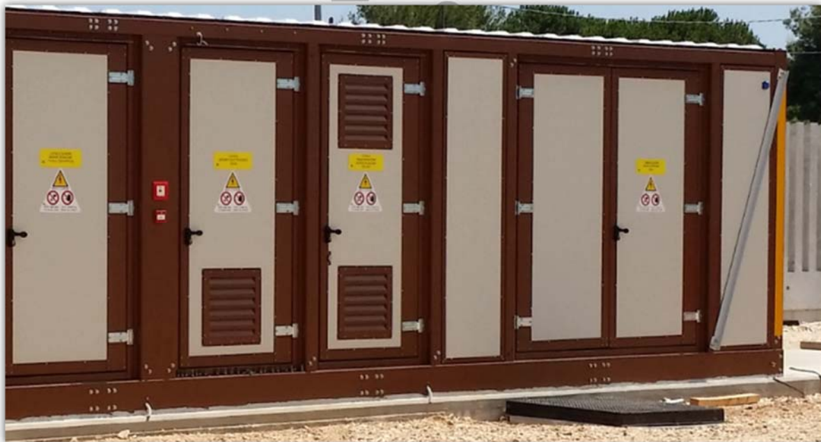
Fig. 28. Foto di edifici tipo shelter.
