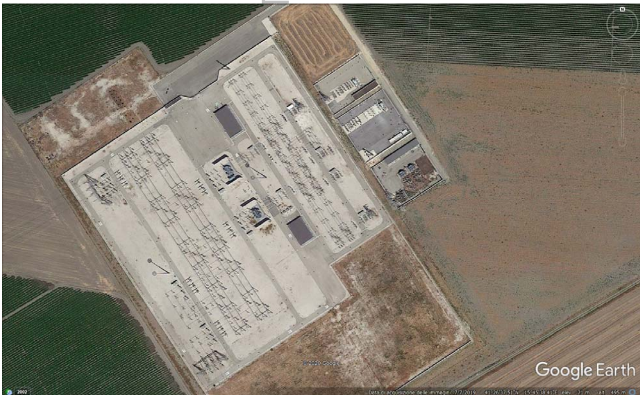
Fig. 31. Stralcio planimetrico su ortofoto su cui è evidente la parte della SE Terna realizzata ed in esercizio.
