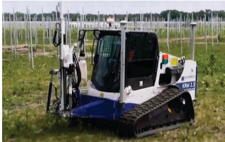
Figura 4.1-1– Esempio di posa delle strutture portanti.
