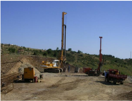
Realizzazione pali trivellati
