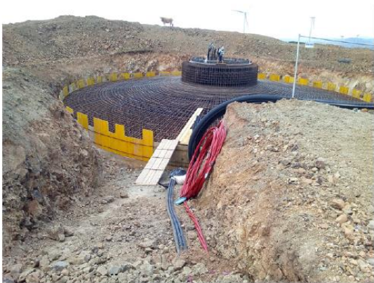
Posa ferri e cassetatura
