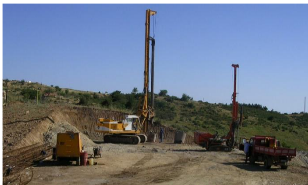
Realizzazione pali trivellati
