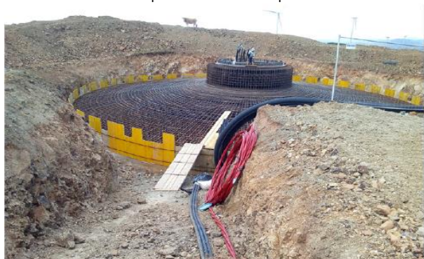
Posa ferri e casseratura
