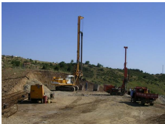
Realizzazione pali trivellati
