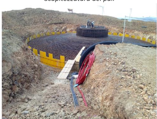
Posa ferri e casseratura
