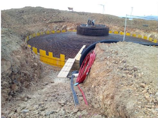
Posa ferri e cassetatura
