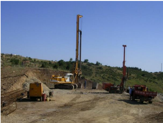
Realizzazione pali trivellati
