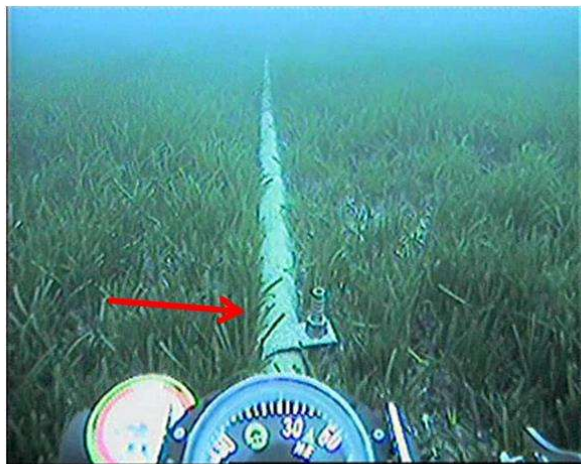
Esempio di cavidotto sommerso su prateria a P. oceanica (le frecce indicano i collari di serraggio)
