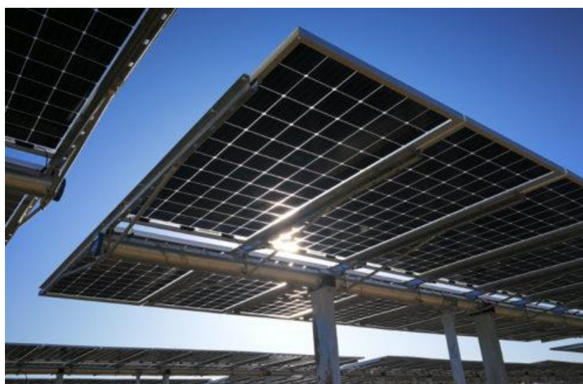
Figura 3.3 Esempio di struttura a tracker monoassiale
