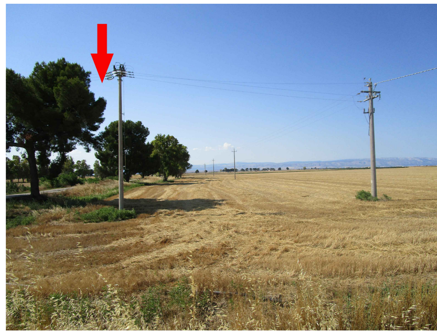
P.O. 39 Masseria Inacquata - Post Operam
