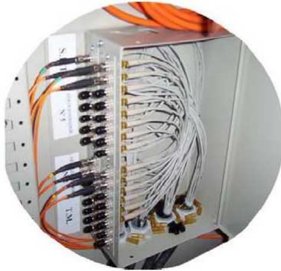
Figura 5 | Scatola di distribuzione per connessione fibre ottiche
