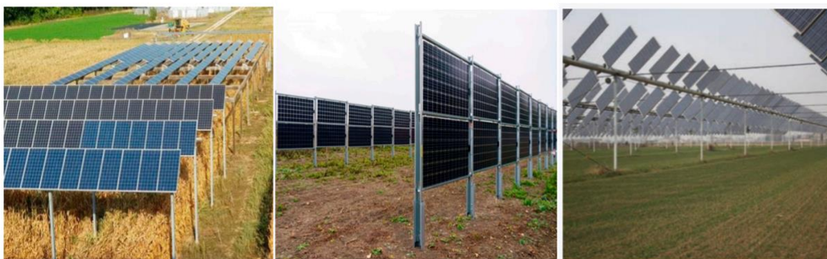
Figura 3. Esempi di differenti soluzioni agrivoltaiche: impianti fissi (Legambiente, 2020); moduli verticali; sistemi di inseguimento (Toledo e Scognamiglio, 2021); Sistema Agrivoltaico® (hiips://remtec.energy/agrovoltaico ).
