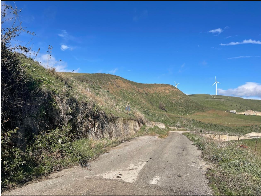
Foto 17 - Panoramica UR 02 (area passaggio cavidotto interrato)
