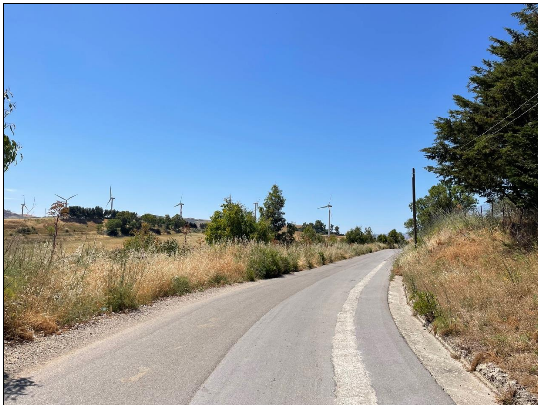
Foto 24 - Panoramica UR 04 (area passaggio cavidotto interrato)
