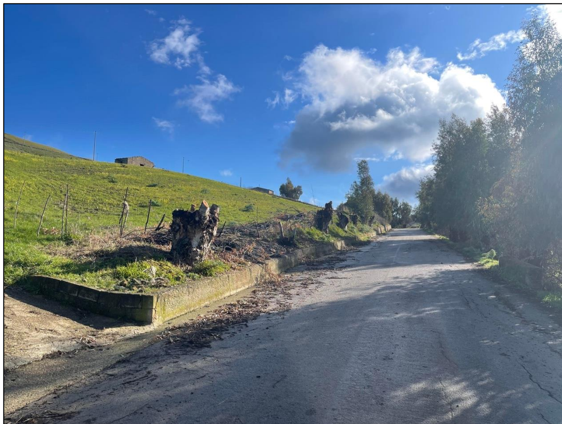
Foto 19 - Panoramica UR 03 (area passaggio cavidotto interrato)
