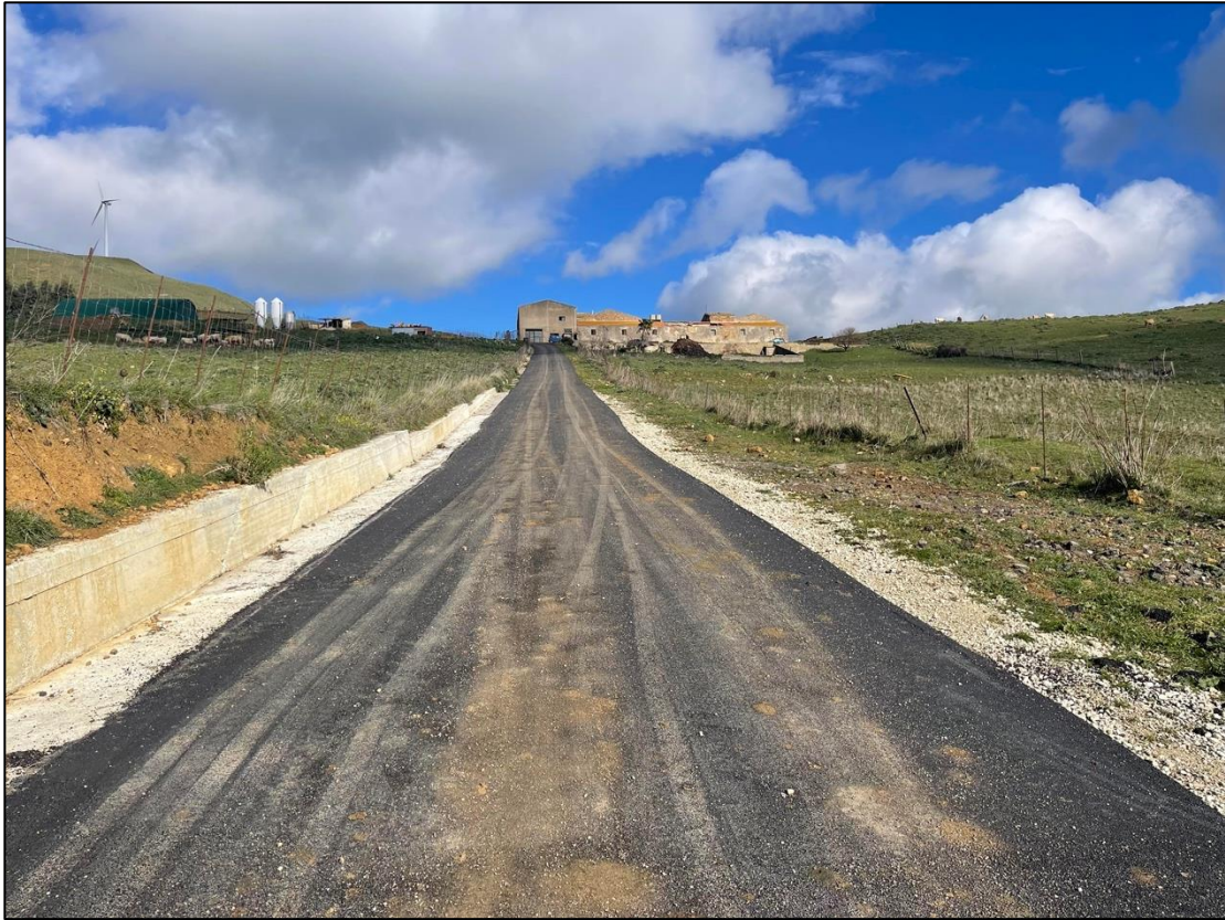
Foto 13 - Panoramica UR 02 (area passaggio cavidotto interrato)
