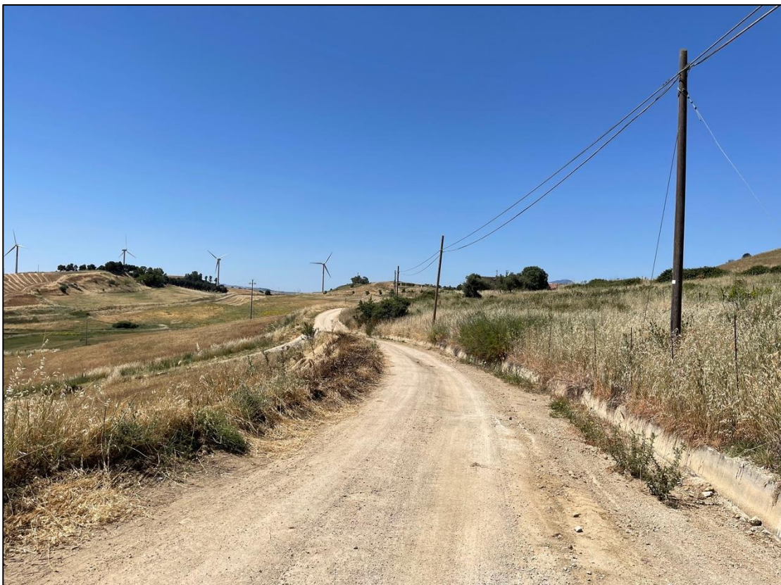
Foto 26 - Panoramica UR 04 (area passaggio cavidotto interrato)
