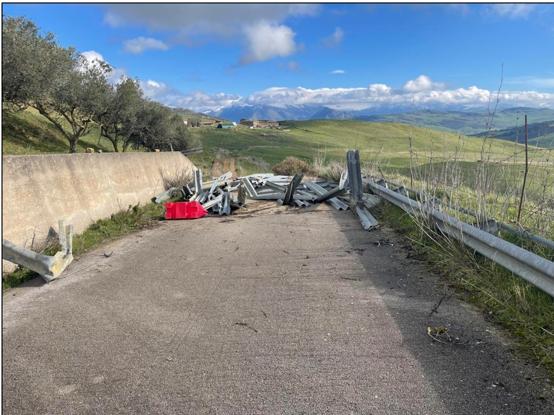
Foto 16 - Panoramica UR 02 (area passaggio cavidotto interrato)
