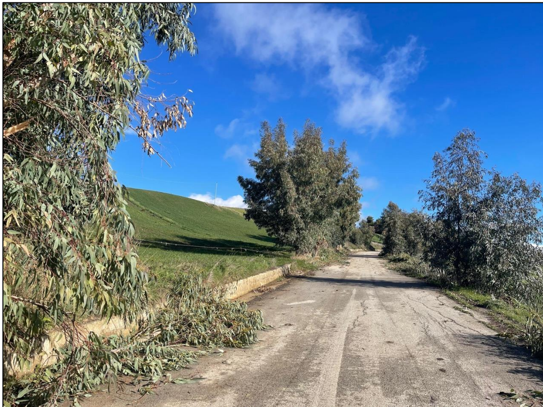
Foto 18 - Panoramica UR 02 (area passaggio cavidotto interrato)
