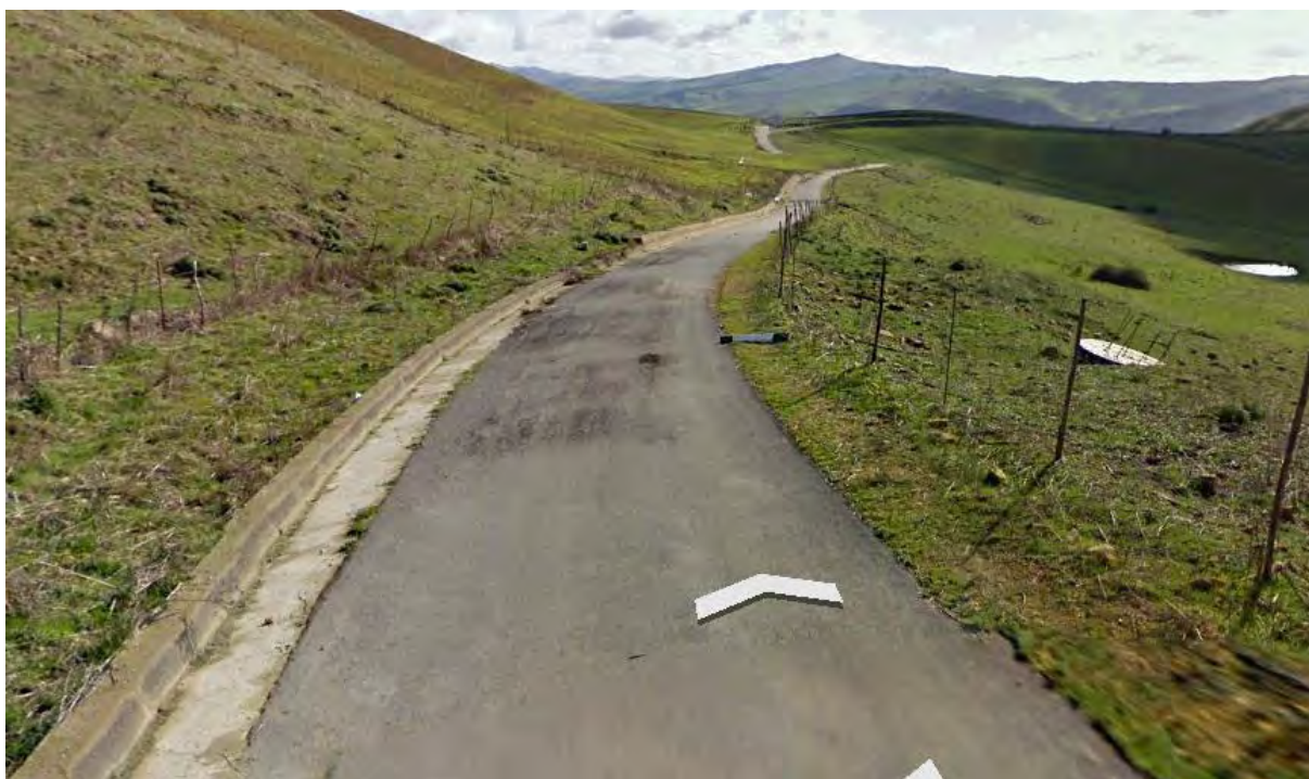
Figura 4.42. un tratto di strada che permette l'accesso all'area di cantiere Fonte Google Earth.
