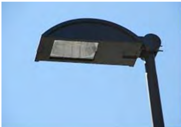
Figura 4.46: Esempio di apparecchio completamente schermato (full-cut-off).
