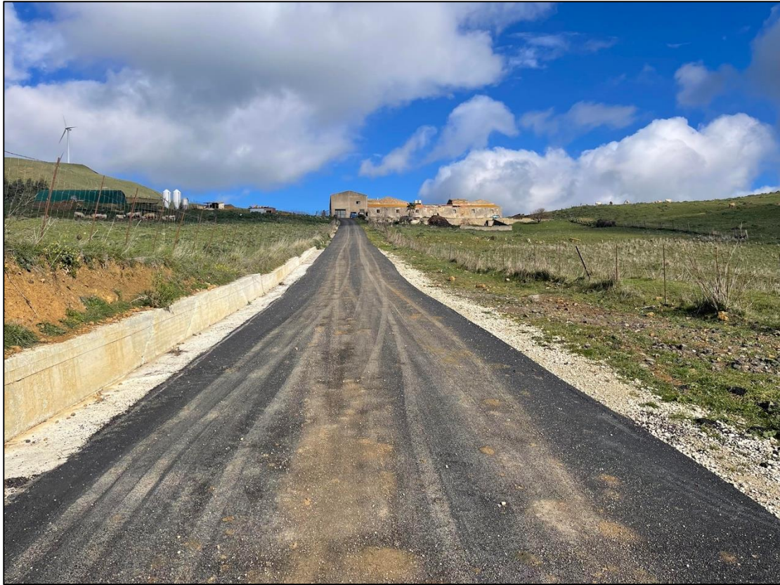
Foto 13 - Panoramica UR 02 (area passaggio cavidotto interrato)
