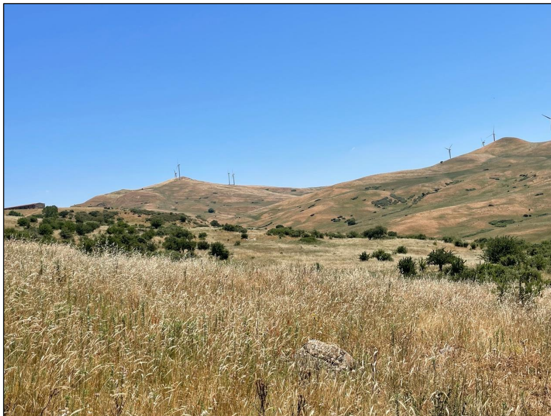
Foto 11 - Panoramica UR 01 (area impianto 3)
