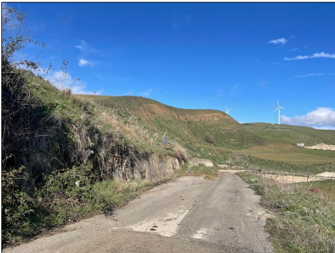
Foto 17 - Panoramica UR 02 (area passaggio cavidotto interrato)
