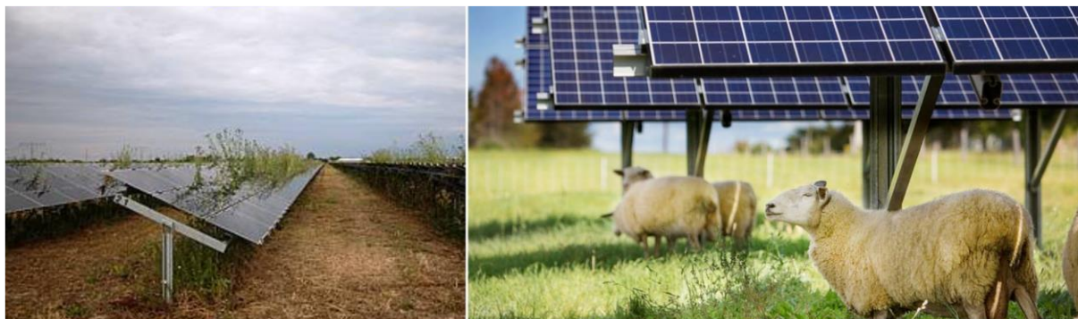
Figura 1.3: Crescita non controllata dalle erbe infestanti in un impianto fotovoltaico.
