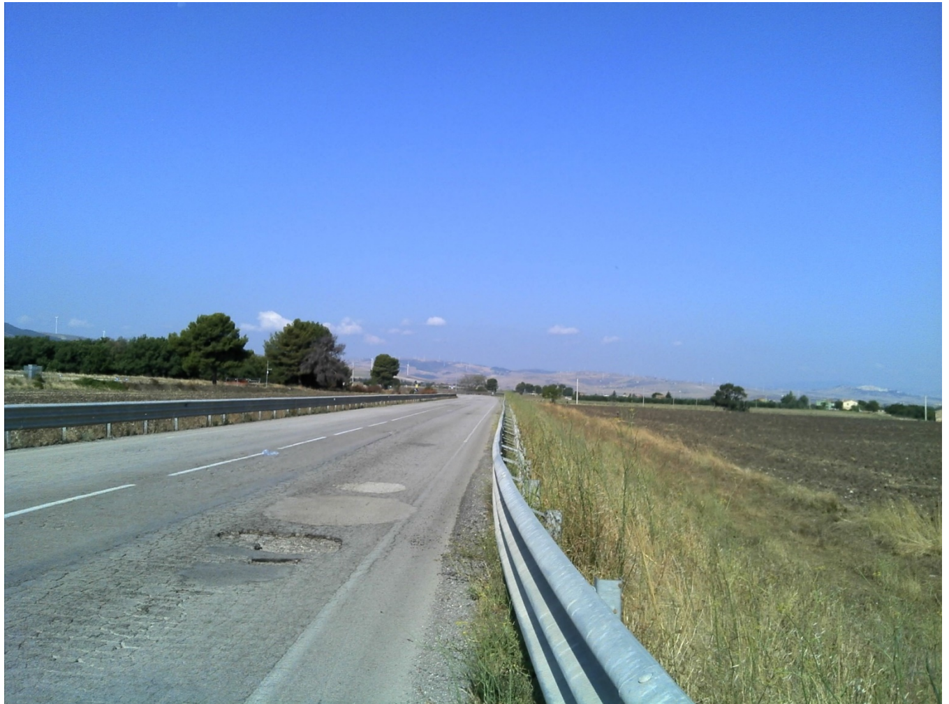
Punto di vista 2, lungo la strada provinciale del basso melfese, ante operam.
