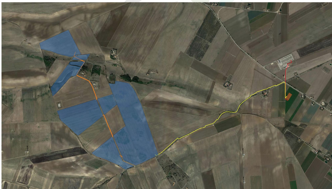
Fig. 1-1: Localizzazione area di intervento, in blu la perimetrazione del sito, in giallo il tracciato della connessione, in arancio l'area della SSEU
