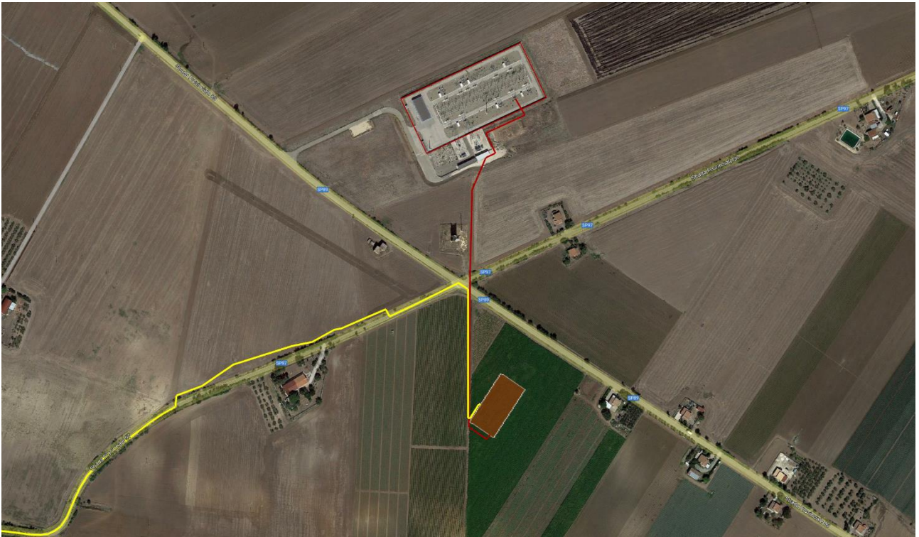
Dettaglio del sito Sottostazione
