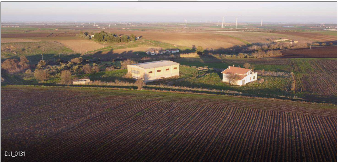
Foto_drone_7.1 - Foto visuale nord-est
