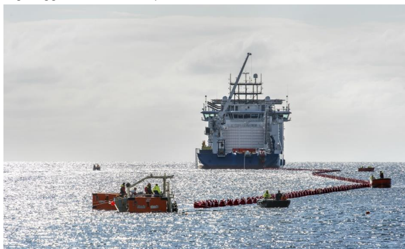
Figura 8.7: posa del cavo in corrispondenza del punto di approdo
