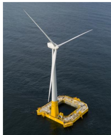
Sottostruttura stabilizzata da figura di galleggiamento, tipo chiatta con specchio d'acqua interno di smorzamento - Ideol damping pool by Ideol
