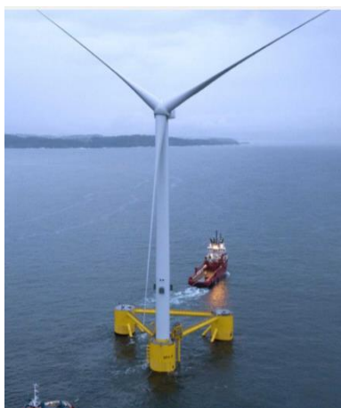
Sottostruttura stabilizzata da figura di galleggiamento, tipo semisommersibile - WindFloat by Principle Power
