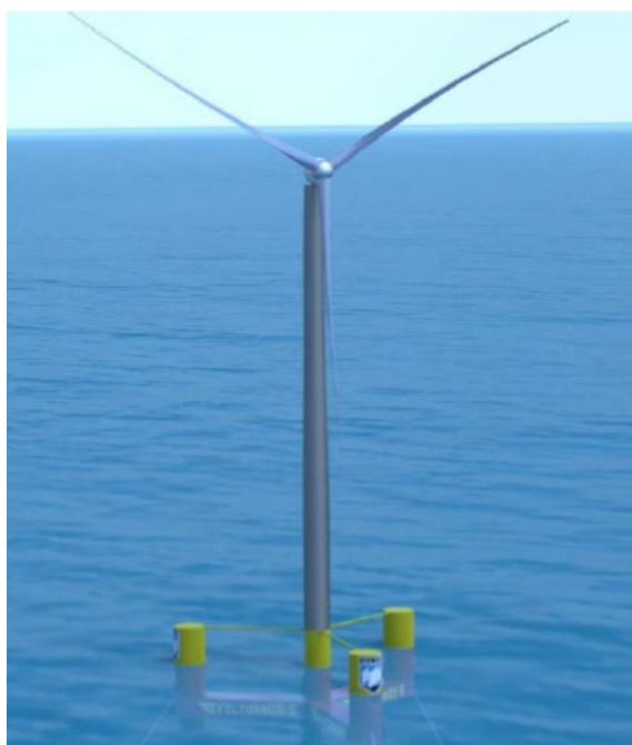
Figura 2.1: La turbina eolica offshore di riferimento "IEA Wind 15MW offshore reference wind turbine" (si prega di notare che, per il presente progetto, solo le caratteristiche del rotore, della navicella, e della torre sono state considerate, non considerando le caratteristiche della sottostruttura)
