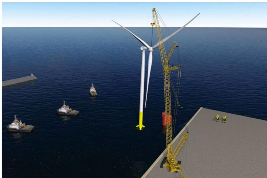
*Montaggio di un aerogeneratore in banchina*
