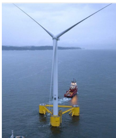
Figura 5.2 Sottostruttura stabilizzata da figura di galleggiamento, tipo semisommersibile - WindFloat by Principle Power
