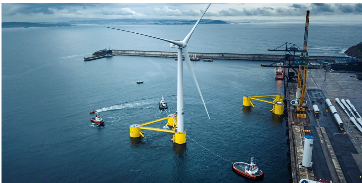
Figura 2. Una piattaforma viene rimorchiata dopo l'installazione della turbina a Ferrol Outer Harbor, in Spagna. Una seconda piattaforma attende la sua turbina in banchina (crediti: Principle Power. Artista: DOCK90).
