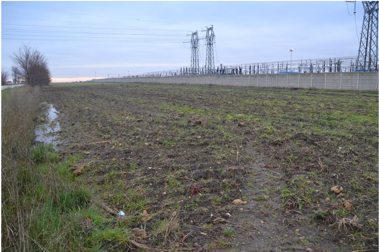
L'U.R. 3, vista da Nordest.
