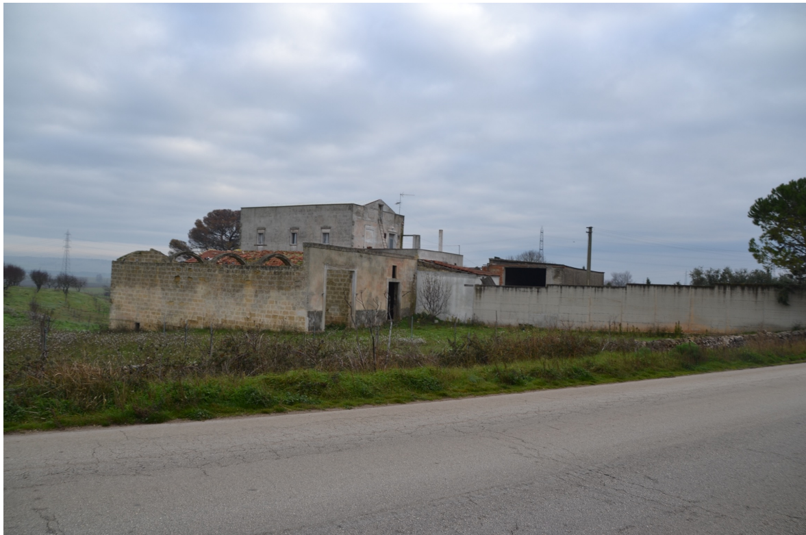
L'U.R. 13, vista da Sudovest.
