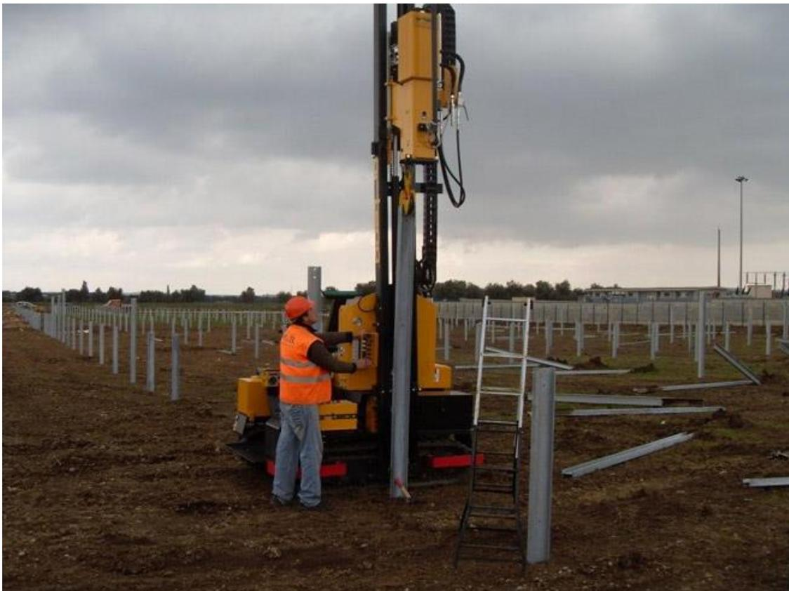
Figura 6 – Modalità di posa pali con macchina battipalo
