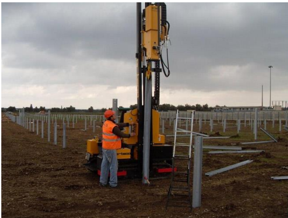
Figura 6 – Modalità di posa pali con macchina battipalo
