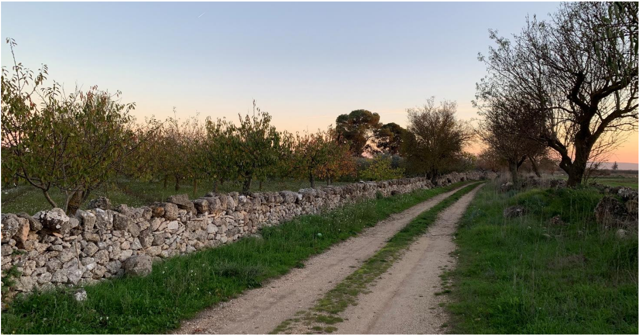
Vista 24b – Stato di fatto
