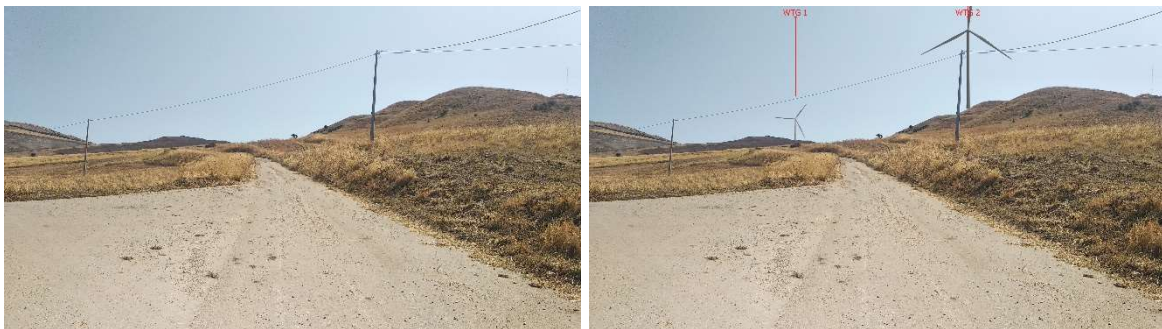
Scatto dal punto P10 (a): ante operam - post operam
