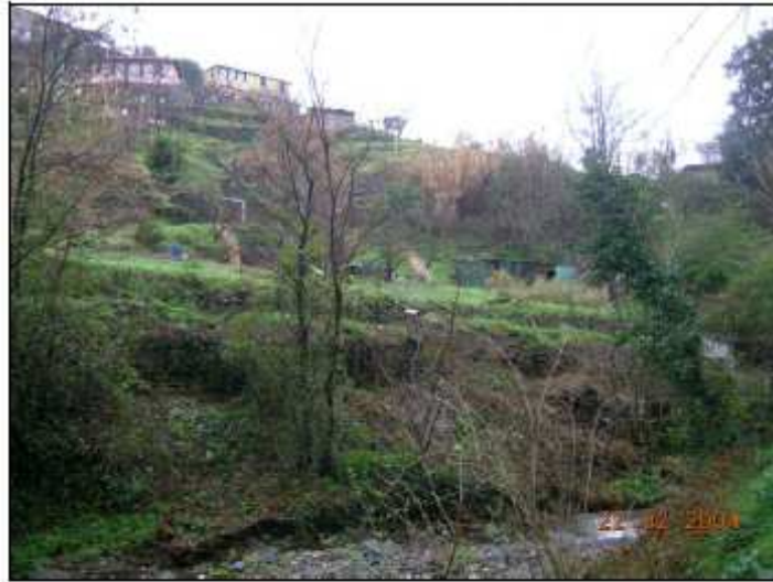
Foto n.3: vista della base del versante nel tratto tra le sezz. 17-25 sistemato al piede con gabbionate che sostengono il materiale riportato con la posa in opera degli oleodotti
