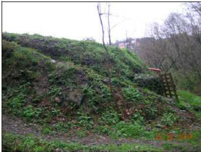
Foto n.5: vista su un taglio nella copertura superficiale alla base del versante; è stimabile uno spessore di 2,5-3m
