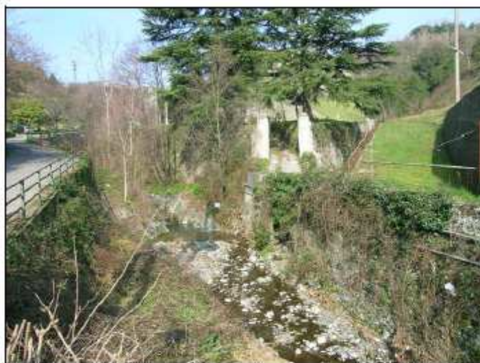
Foto n. 1: vista verso monte dal ponte attuale sul T. Ciliegio; è visibile l'affioramento in argilliti della soglia naturale del corso d'acqua
