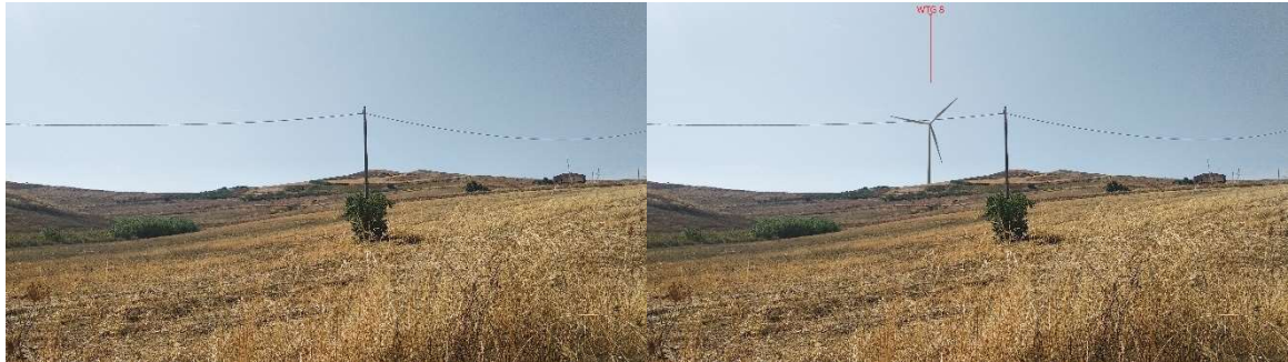
Scatto dal punto P01 (b): ante operam - post operam
