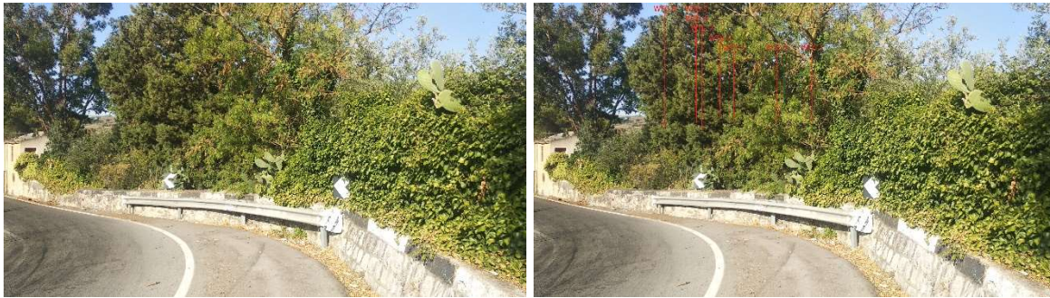
Scatto dal punto P15: ante operam - post operam
