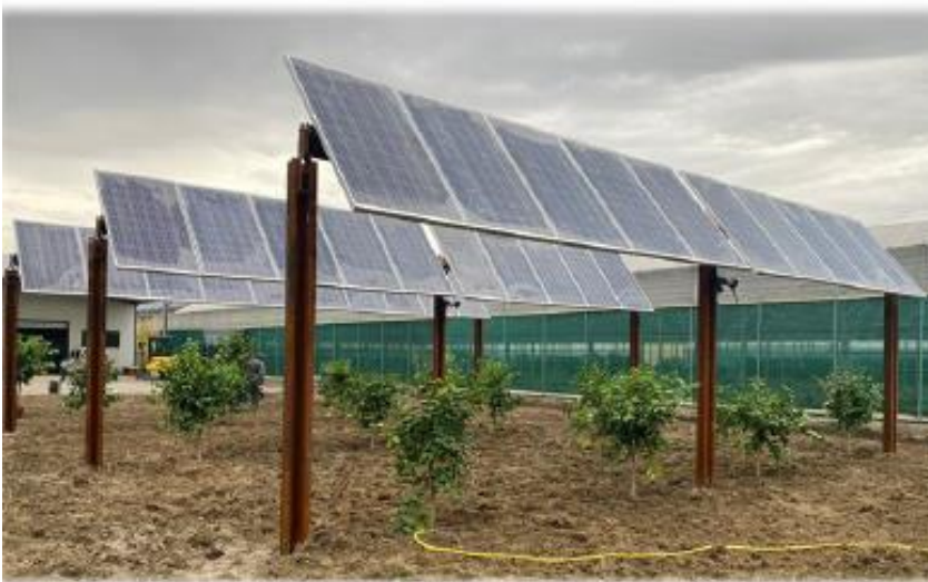
Figura 2: Tracker per agro-fotovoltaico
