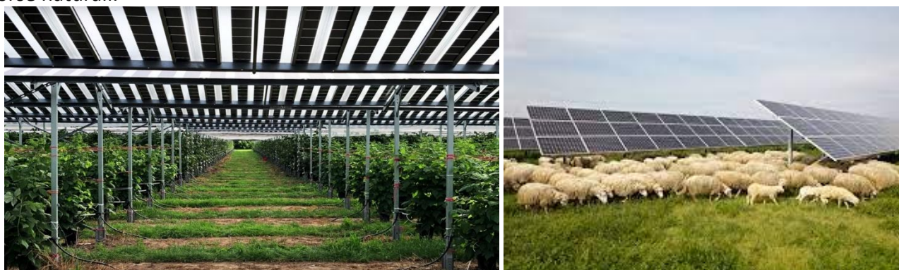
Figura 52: Esempio di agrovoltaico (fotovoltaico con sottostante coltivazione, a sinistra, o pascolo, a destra)
