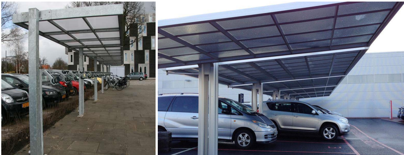
Figura 72: possibile riuso dei tracker come sostegni per pensiline con o senza pannelli solari (Fonte: immagine a sinistra: https://www.falco.co.uk/ ; immagine a destra: https://www.canopiesuk.co.uk/ )
